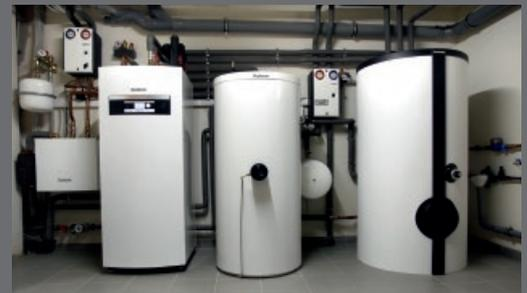
Sole-Wasser-Wärmepumpe Logatherm WPS
