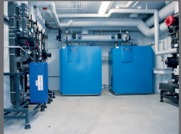
HAST-AKKU® als Hausanschlussstation für Kesselanlage
