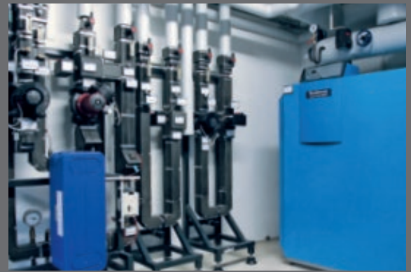
HAST-AKKU® als Hausanschlussstation für Kesselanlage
