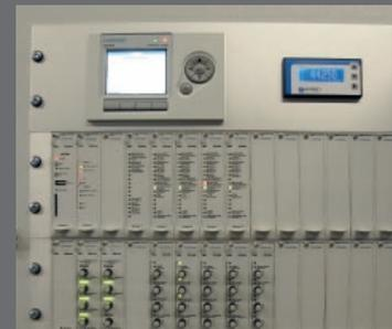
Über einen Schaltschrank lassen sich die Kessel zu- und abschalten.
