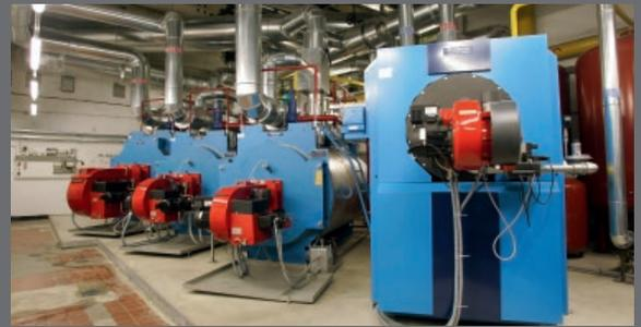
Drei Logano S825 unterstützen den Logano plus SB735 bei Bedarf.
