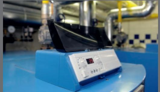
Die Kesselregelung setzt die Vorgaben der übergeordneten Regelung um und stellt einen optimalen und effizienten Betrieb sicher.
