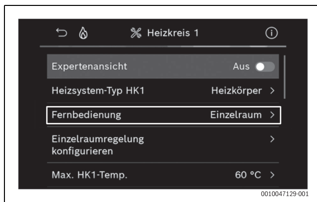
Bild 3 Beispiel Gas-Brennwertgerät; Einzelraumregelung Heizkörper
