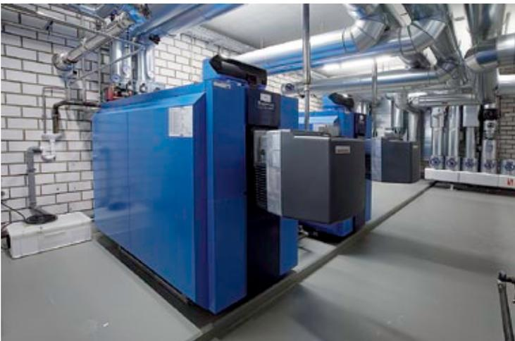
*Die Gas-Brennwertkessel Logano plus SB625 in den Leistungsgrößen von je 300 kW nutzen den eingesetzten Brennstoff besonders effizient.*
