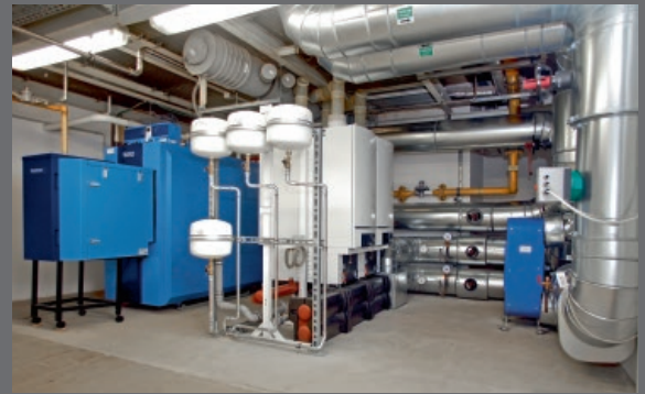
Modernes Gas-Brennwertsystem.
