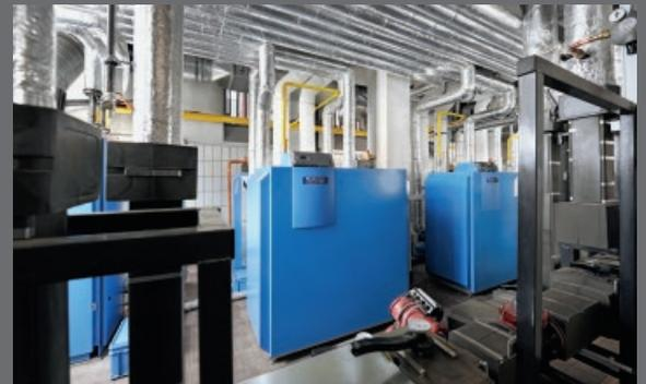
Mit einer Kapazität von insgesamt 12.000 Litern sorgen die sechs Pufferspeicher dafür, dass immer warmes Trinkwasser zur Verfügung steht.
