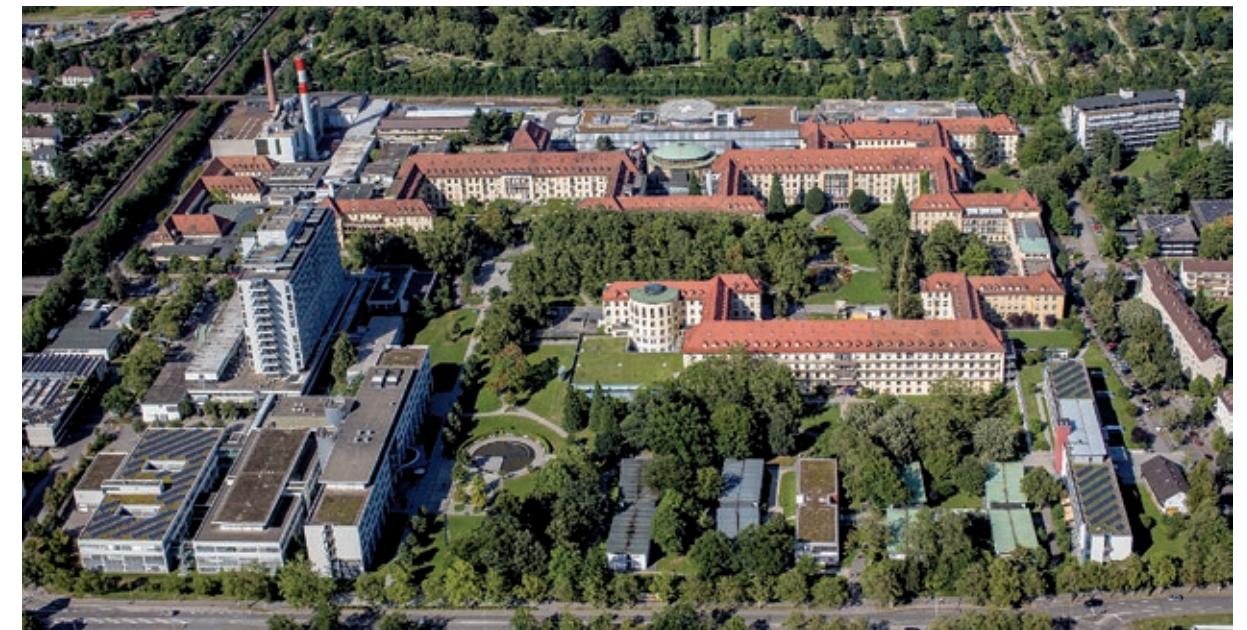
Das Universitätsklinikum Freiburg beschäftigt an zwei Standorten über 15.000 Mitarbeitende und verfügt über ein eigenes Heizkraftwerk, welches eigene und externe Liegenschaften mit Wärme, Strom und Kälte versorgt.
