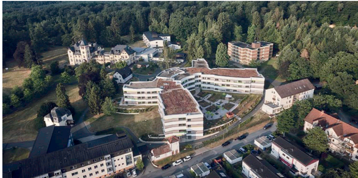
Einrichtungen des Gesundheitswesens können ihre laufenden Energiekosten durch effiziente Heiz- und Klimatisierungstechnik deutlich senken.
